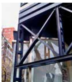
Pórticos isostáticos de estructura de acero arriostrado con diagonales.
