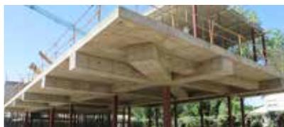
Idea de sobreingeniería estructural en hormigón
